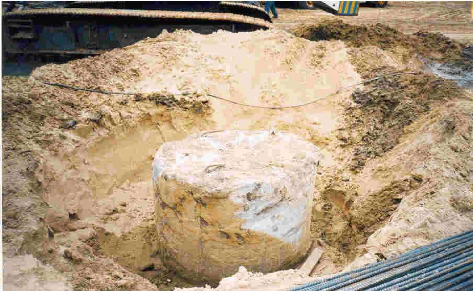
Estaca concretada, pronta para ser arrasada
