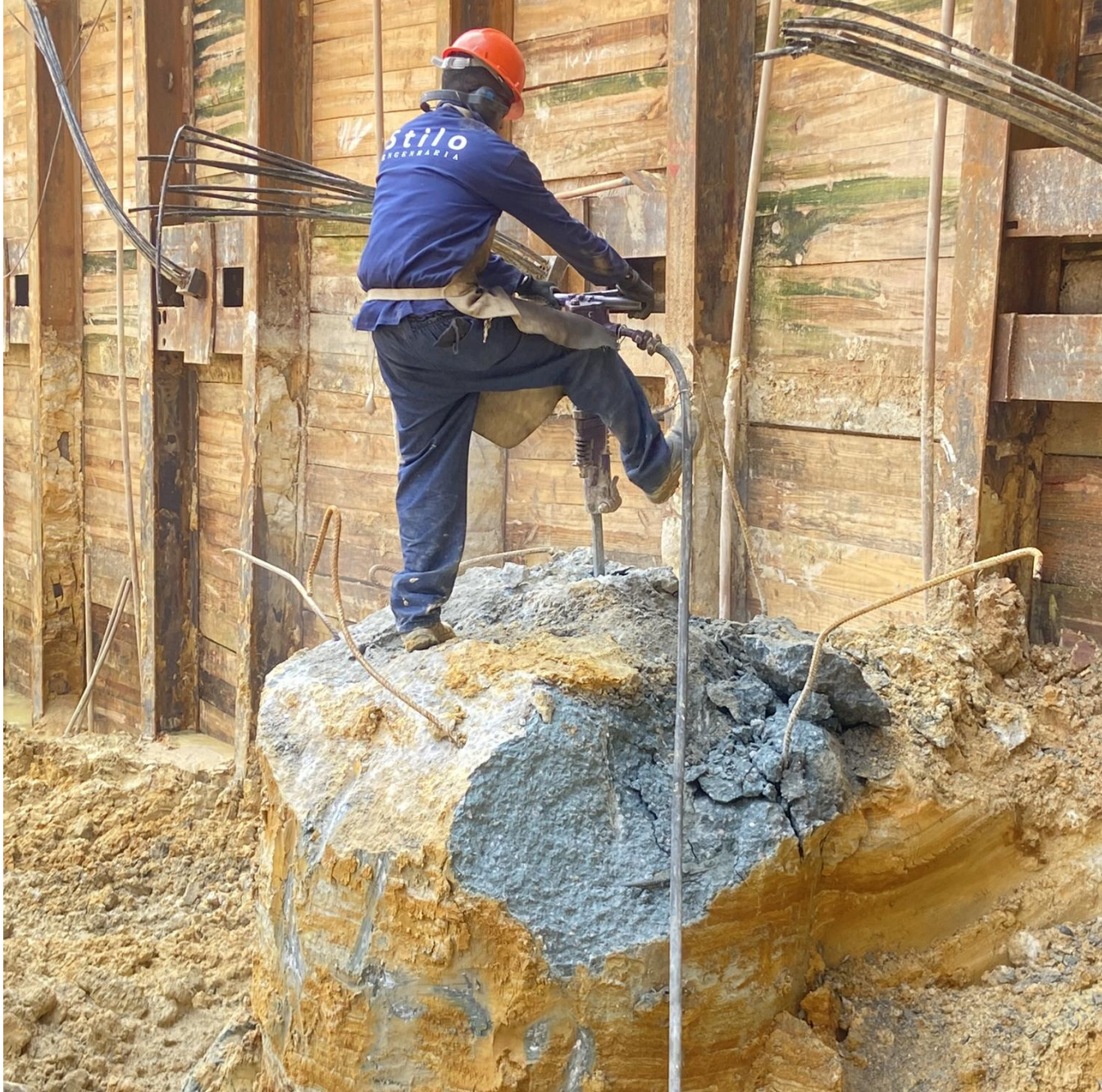
Bloco de coroamento — escavação e concretagem (7.000 m 3 )
