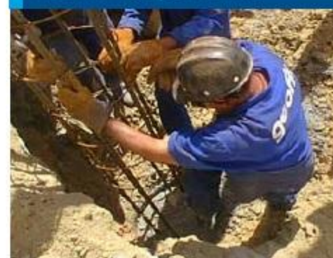
Figura 8 • Instalação da armadura
