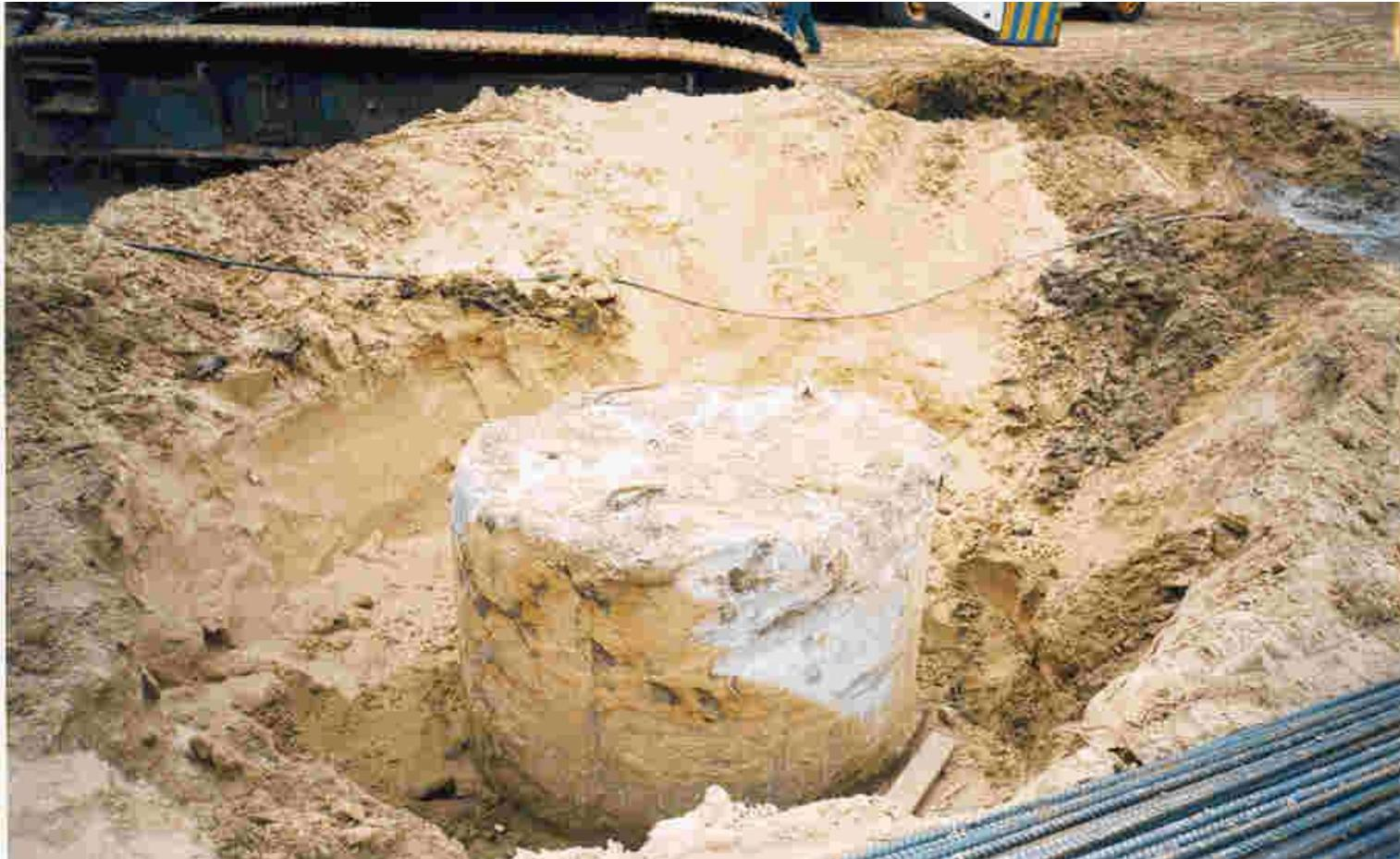
Estaca concretada, pronta para ser arrasada
