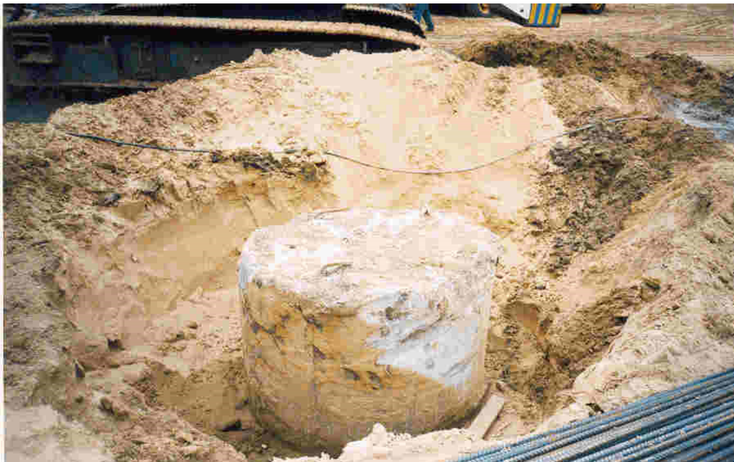
Estaca concretada, pronta para ser arrasada
