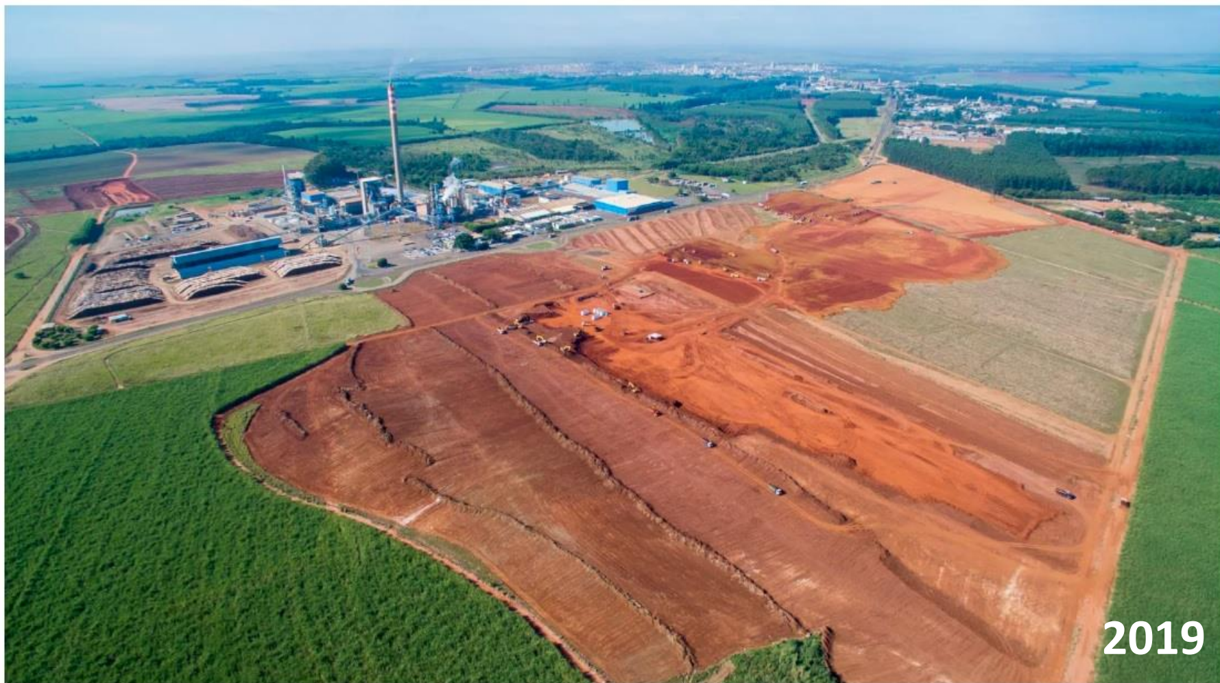
Canteiro de obras da fábrica de celulose ocupa uma área de mais de 1,2 milhão de metros quadrados em Lençóis Paulista — Foto: Grupo Bracell/Divulgação
