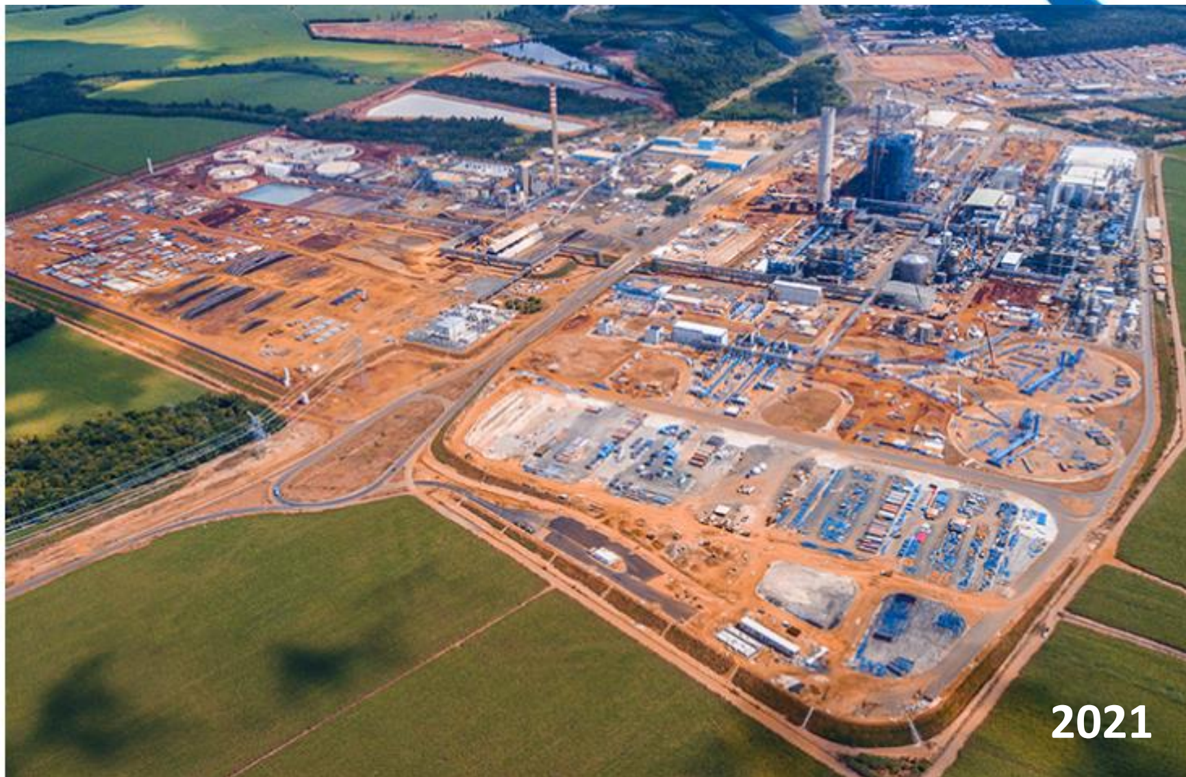
Vista aérea da obra (Fonte: https://www.bracell.com/projeto-star/ )
