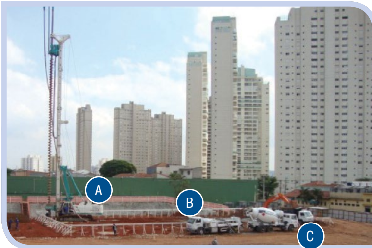
Figura 2: Vista geral da execução de uma estaca hélice contínua
