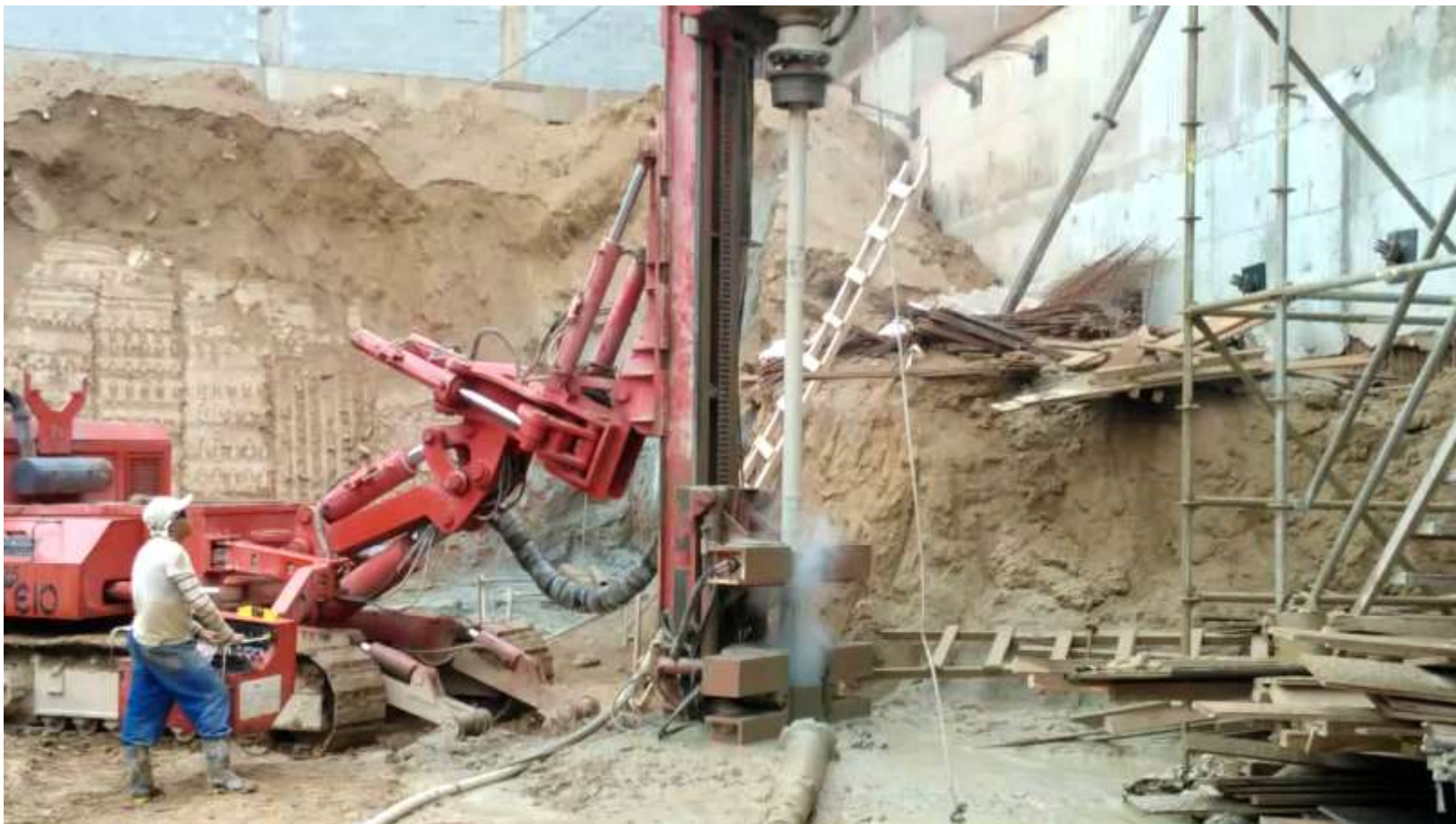
Vídeo: Estaca raiz – perfuração em rocha. Fonte: Acervo ZF.
