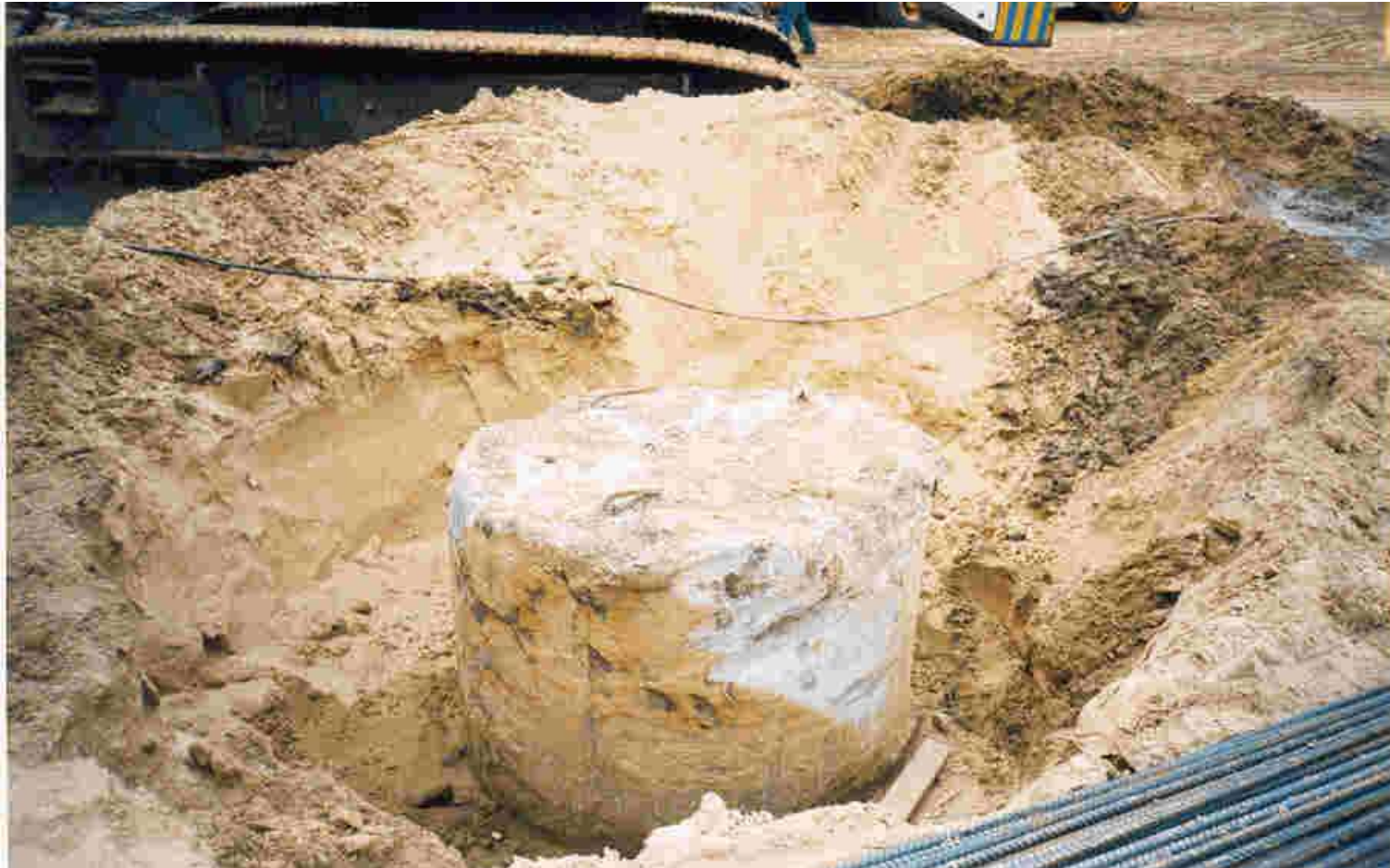
Estaca concretada, pronta para ser arrasada
