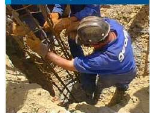
Figura 8 - Instalação da armadura
