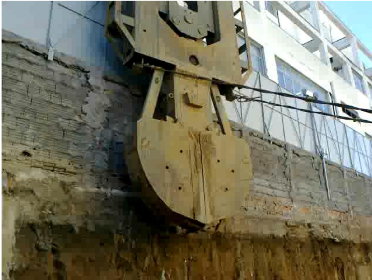
Vídeo: Escavação com “clam shell”. Fonte: Acervo ZF.
