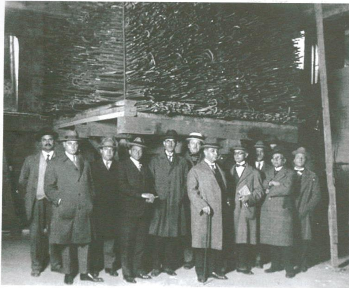
Prova de carga em sapata da fundação do edifício Martinelli
