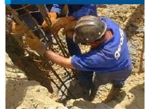
Figura 8 • Instalação da armadura
