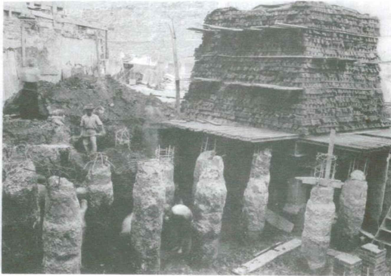
Edif. Banco do Estado de São Paulo - anos 40 - Cargueira de 180 tf
