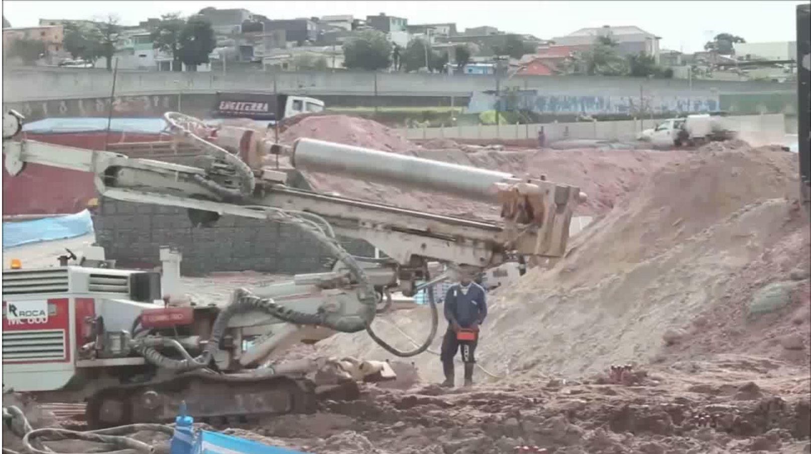
Vídeo: Metodologia executiva – estacas raiz. Fonte: Roca Fundações S/S Ltda.
