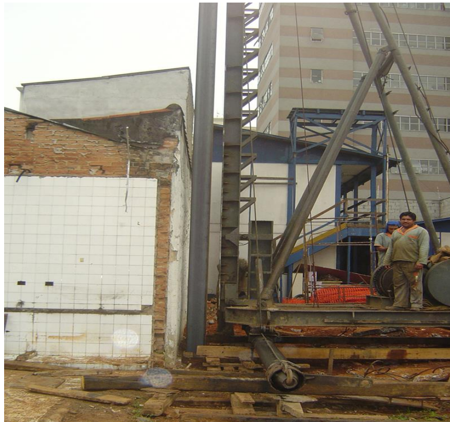
Perfil metálico de contenção junto à divisa
