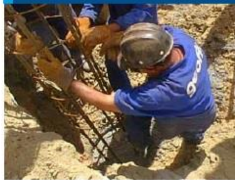
Figura 8 • Instalação da armadura
