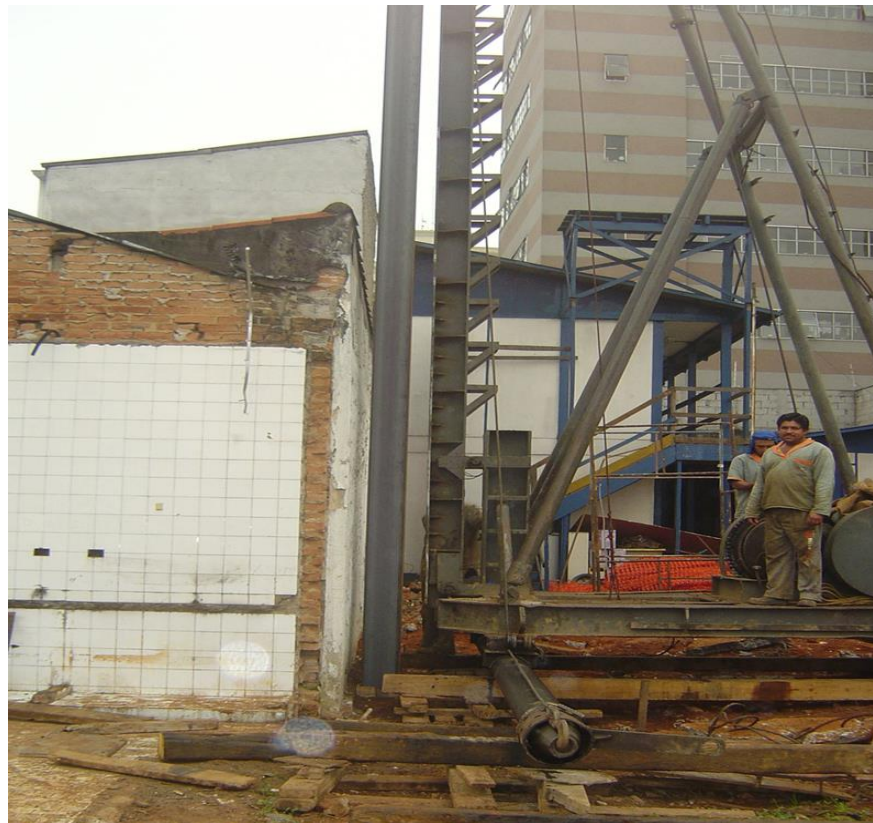
Perfil metálico de contenção junto à divisa
