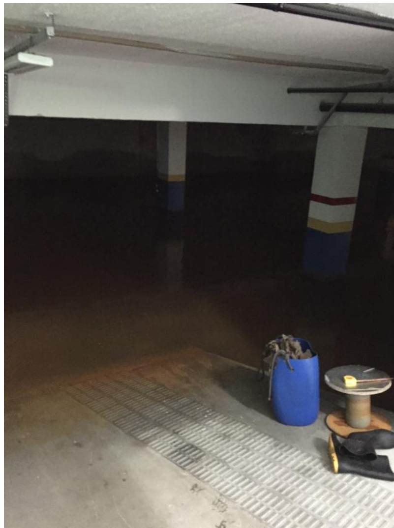
Cenário Inicial – Infiltração com alto fluxo e subsolo submerso
