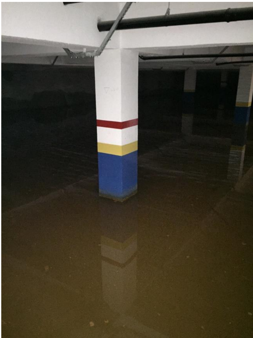
Cenário Inicial – Infiltração com alto fluxo e subsolo submerso
