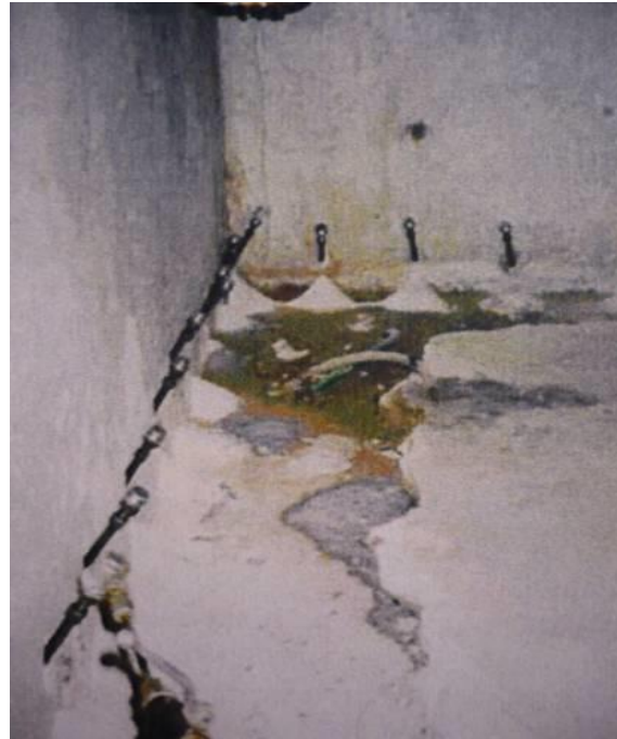
Juntas de Concretagem
