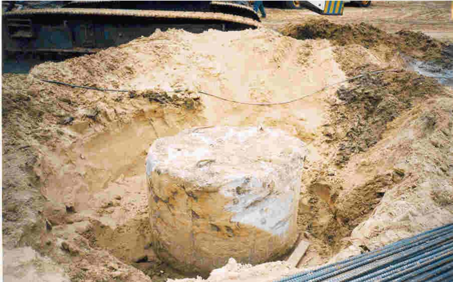
Estaca concretada, pronta para ser arrasada
